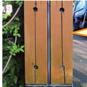
水洗い→リグノブライト →木材保護塗料 (塗り替え後3年経過)
